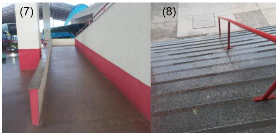
Figura 8 - Escada para transbordo da passarela.
