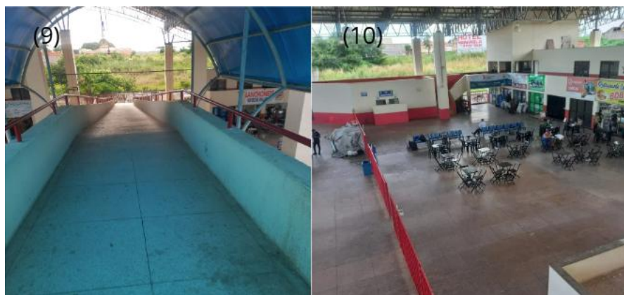
Figura 10 – Saída da passarela para a rampa de acesso ao terminal.
