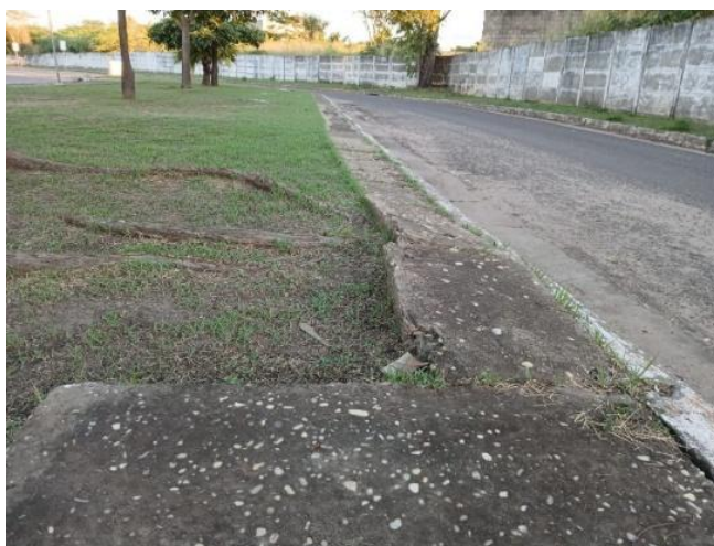
Figura 4 – Calçada na região de entrada do terminal.
