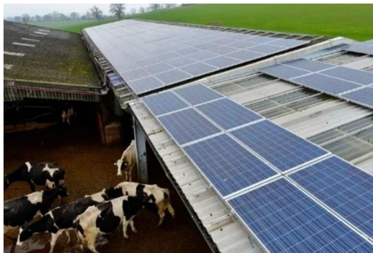
Figura 3- Painéis fotovoltaicos utilizados para sombreamento
