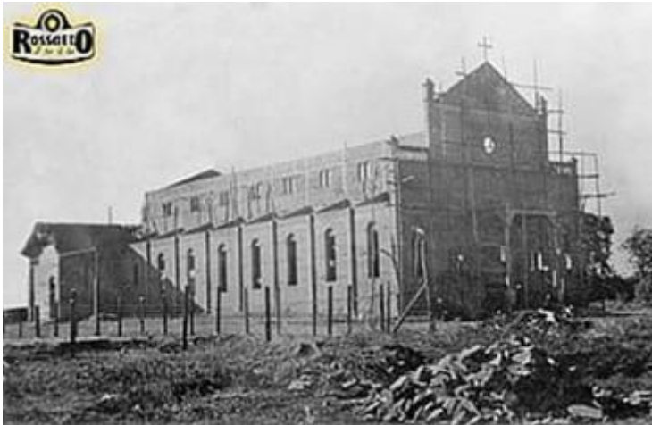
Foto 5: Igreja Matriz sendo construída Fonte: Acervo pessoal.
