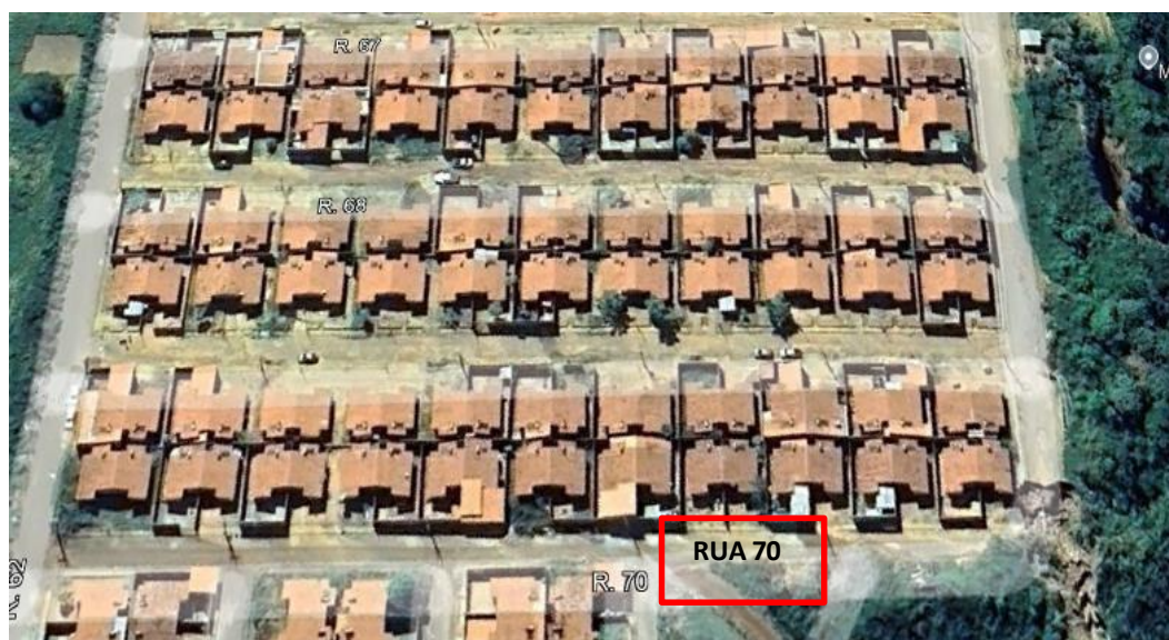
Figura 1 - Rua 70 do bairro Jardim Aulídia
