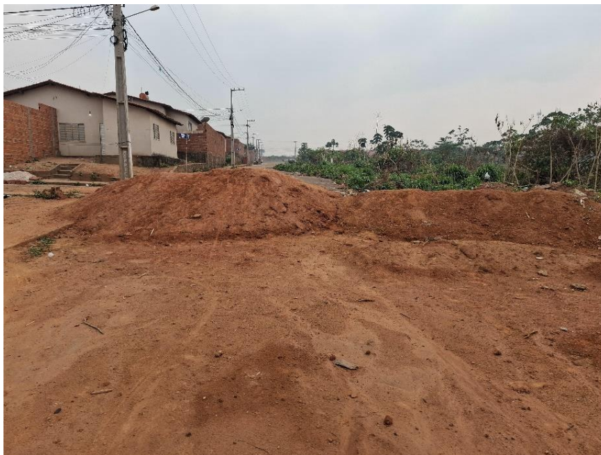
Figura 9 - Montante de barro impedindo a passagem de veículos
