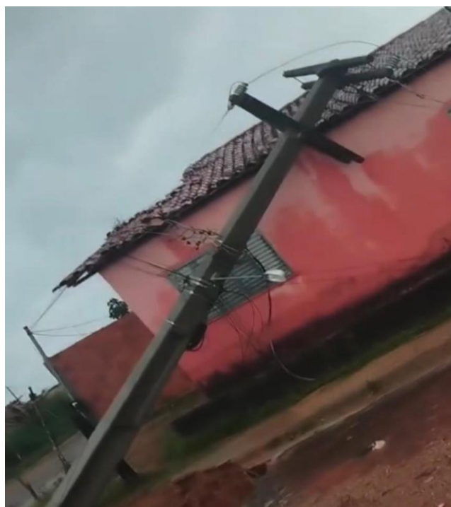
Figura 6 - Poste caído por conta da erosão
