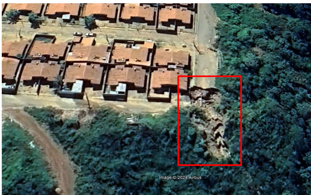
Figura 2 - Google Earth destacando de forma detalhada os efeitos da erosão
