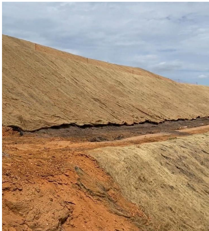
Figura 10 - Aplicação da Biomanta
