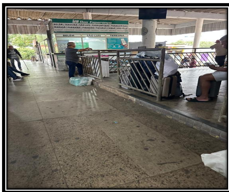
Figura 10 – Ausência de Rampas para acesso à área de espera
