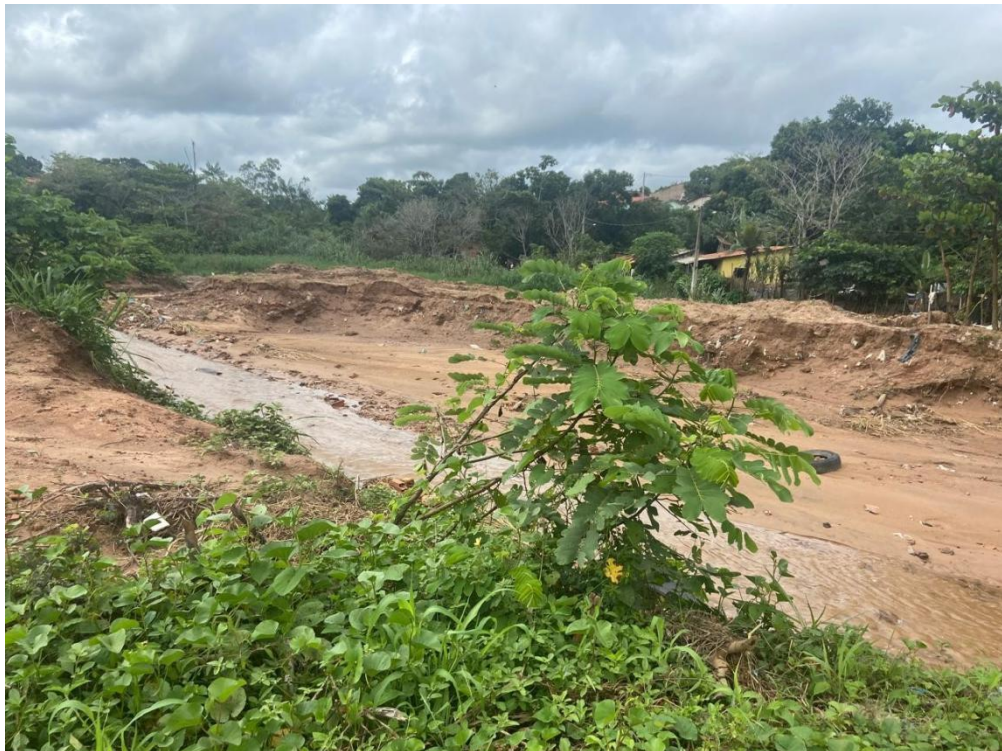
Imagem 5: Trecho do córrego Esperança com sinais de assoreamento e ausência de mata ciliar.
