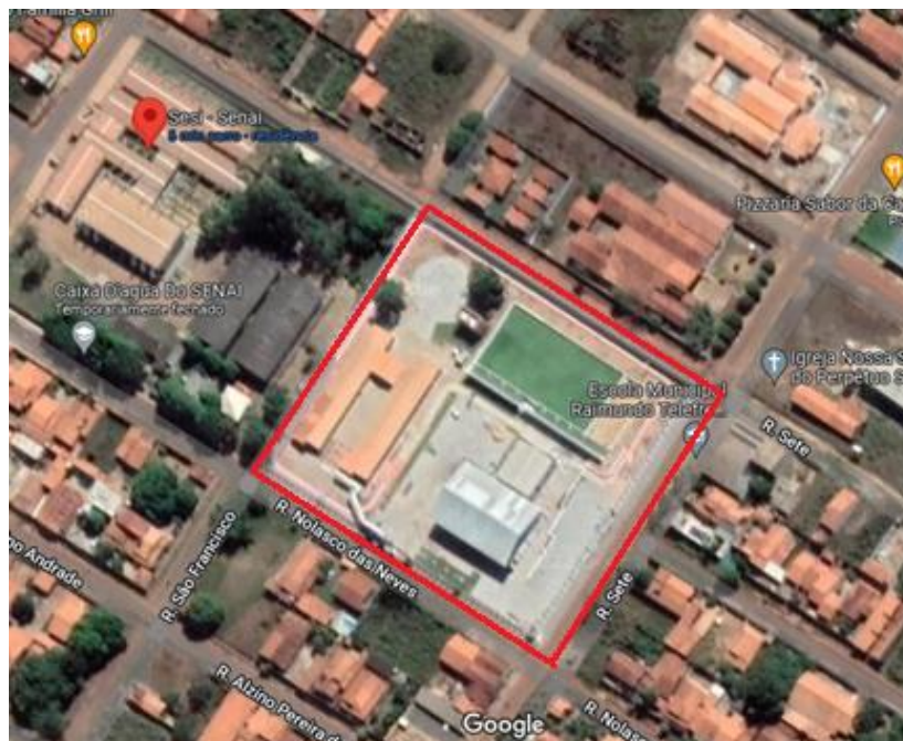
Figura 14 – Localização da construção
