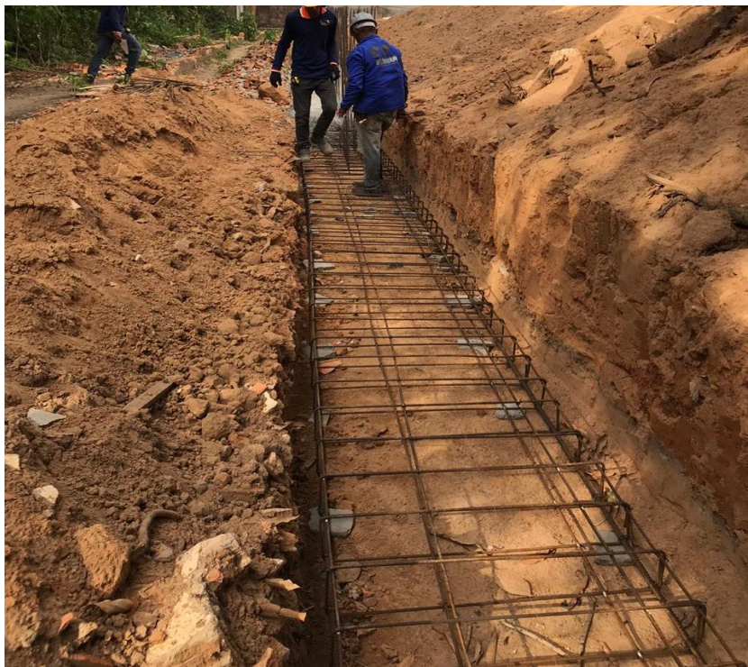
Figura 17 – Amarração da base do muro de arrimo
