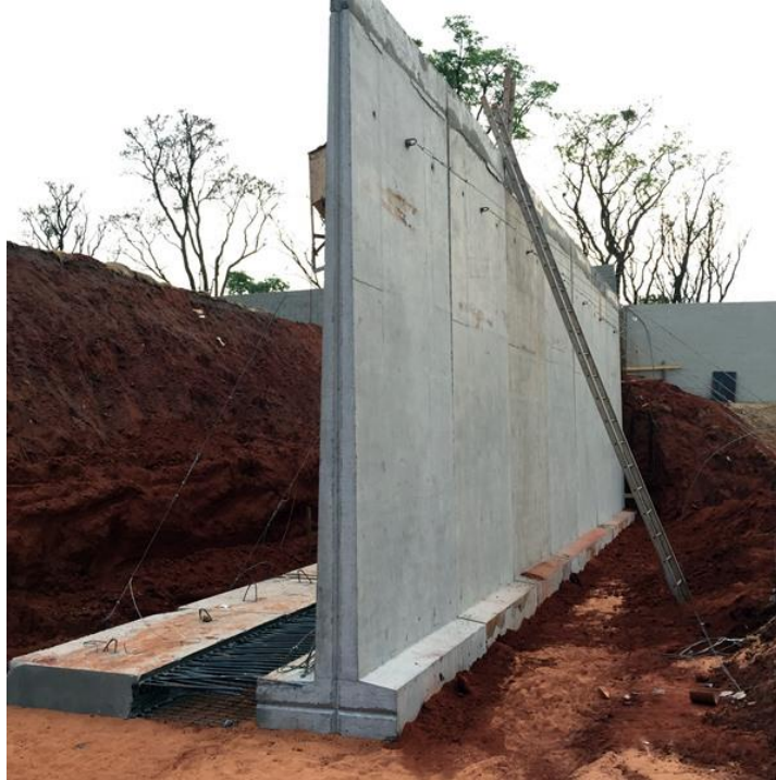
Figura 6 – Muro de arrimo por flexão
