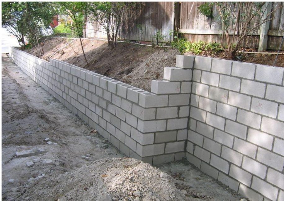
Figura 1 – Muro de contenção
