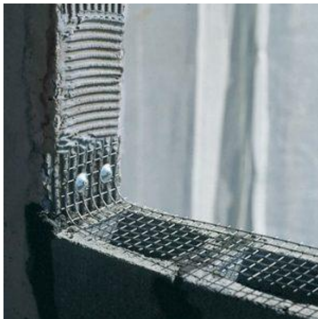
Figura 23 – Ligação de elementos estruturais
