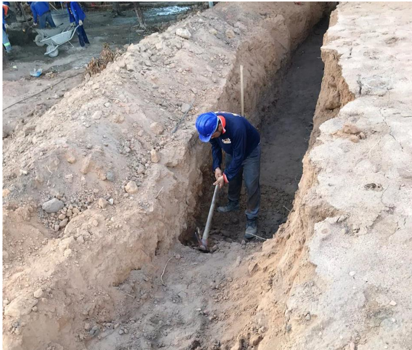
Figura 16 – Escavação manual base do muro de arrimo
