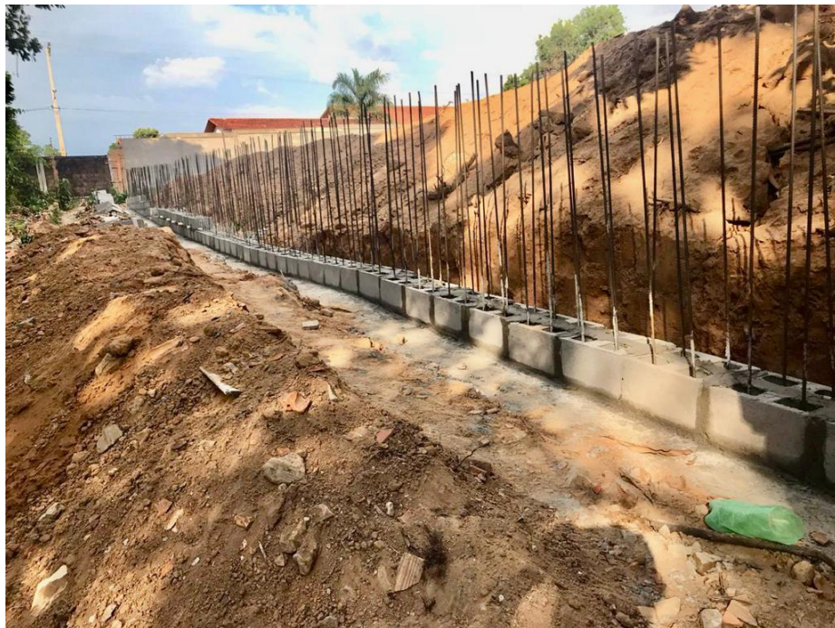
Figura 19 – Levantamento de alvenaria do muro de arrimo
