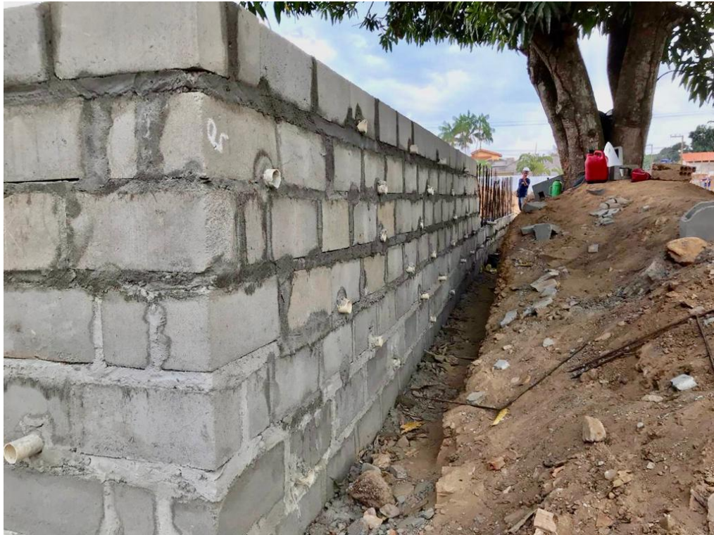
Figura 20 – Levantamento de alvenaria do muro de arrimo
