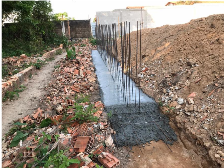
Figura 18 – Concretagem da base do muro de arrimo
