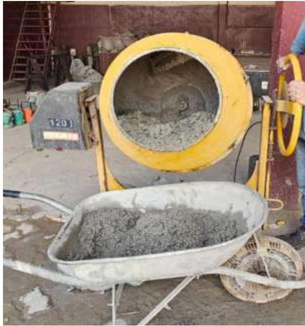
Figura 7: Uso da betoneira para mistura dos materiais.
