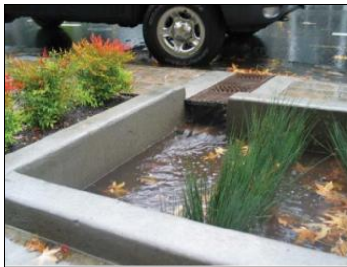
Figura 10 – Aplicação prática de jardim de chuva em calçada urbana.
