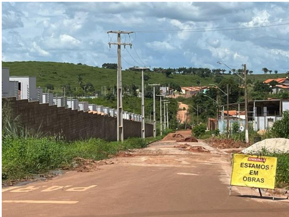
Figura 28 – Execução de obras emergenciais de recuperação.
