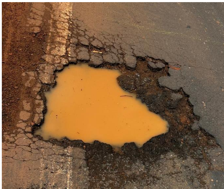
Figura 9 - Evolução de patologias, resultada em panela.
