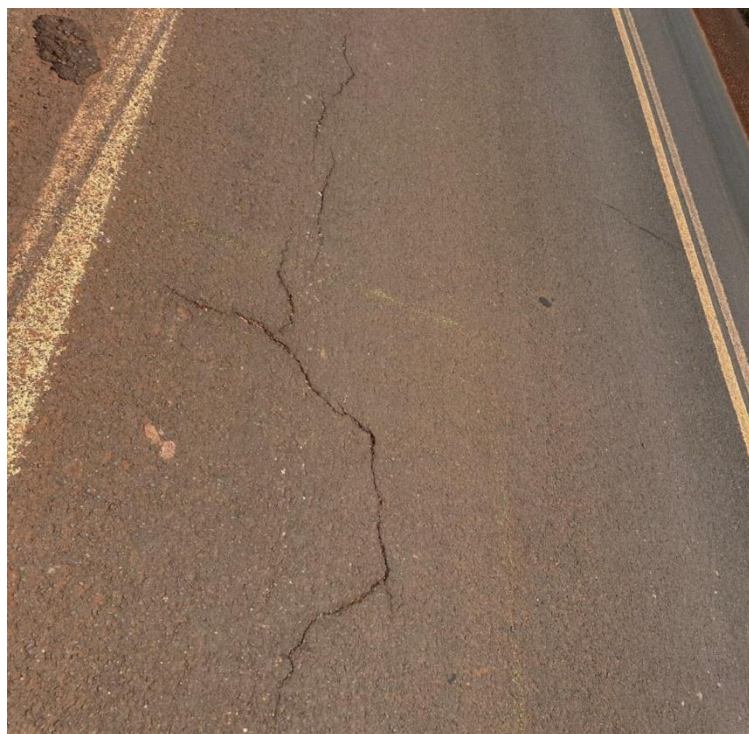
Figura 13 - Fissura longitudinal
