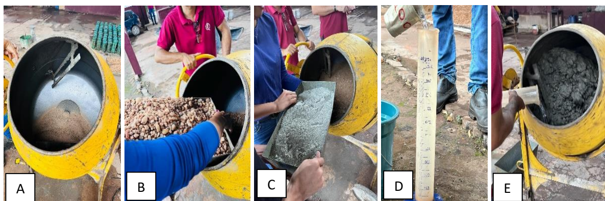
Figura 5 – Preparação do traço de concreto.
