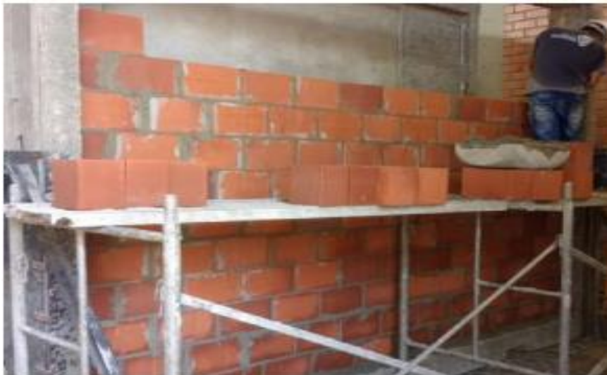
Figura 4: Alvenaria de vedação em blocos cerâmicos
