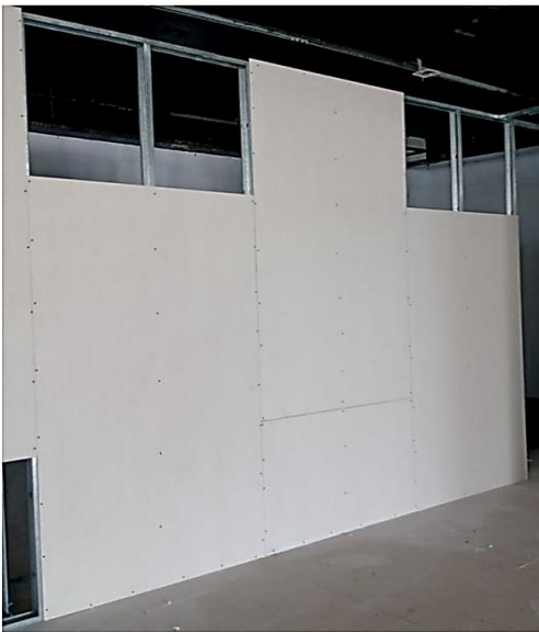
Figura 1: Fixação de chapa
