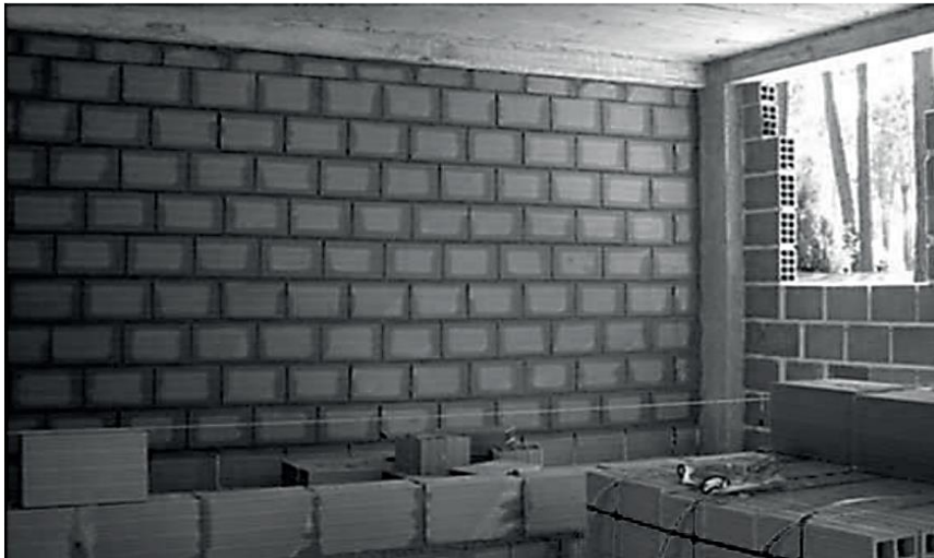
Figura 3: Alvenaria de vedação em blocos cerâmicos
