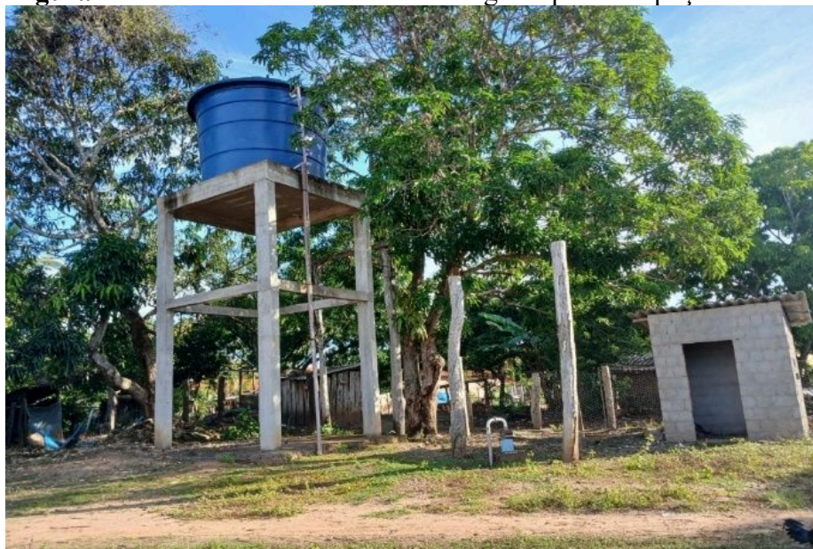
Figura 7 - Sistema de abastecimento de água a partir de poço artesiano
