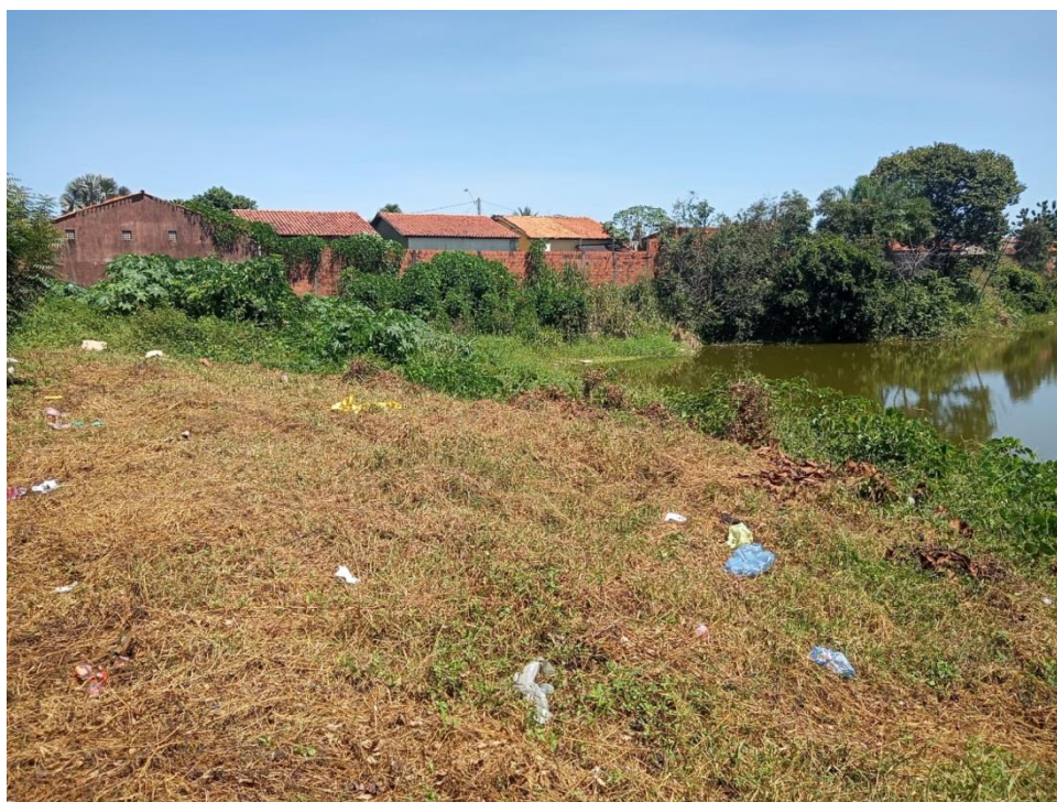
Figura 5. Casas em risco de desmoronamento
