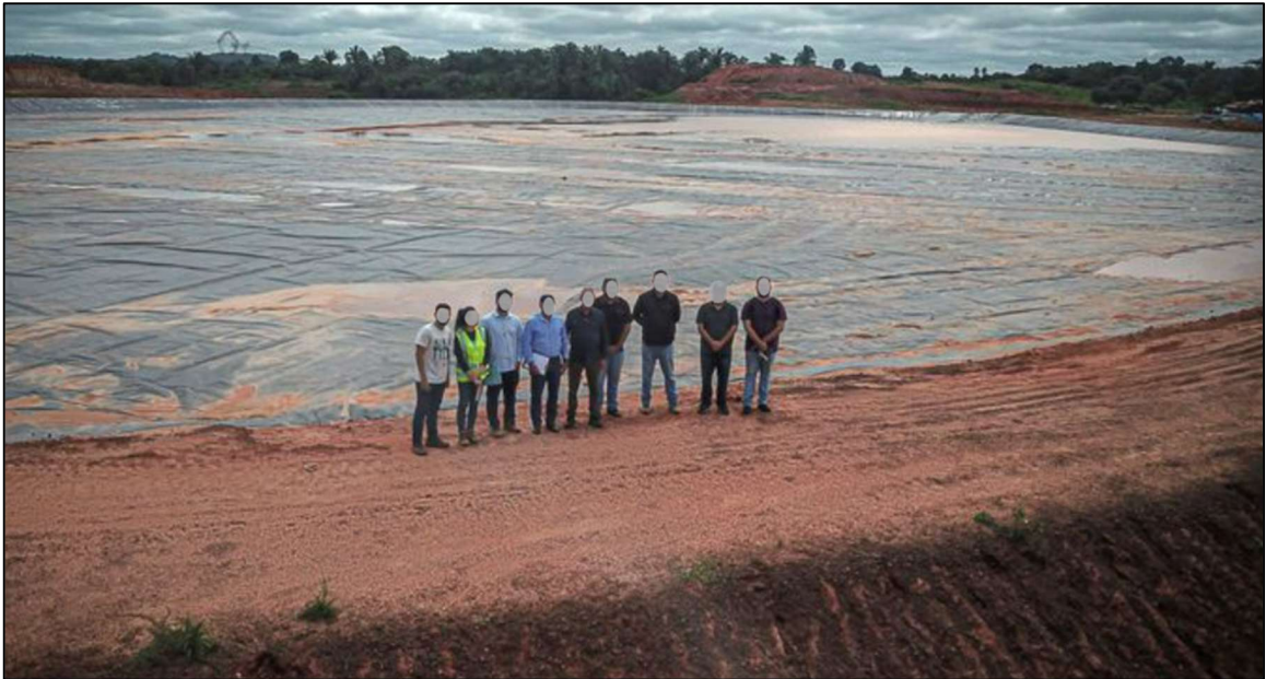
Figura 6 - Andamento da obra de execução do Aterro Sanitário
