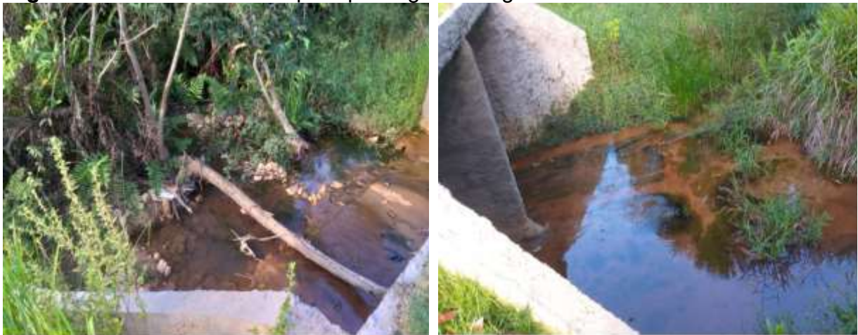
Figura 11 - Canal construído para passagem da água do afloramento
