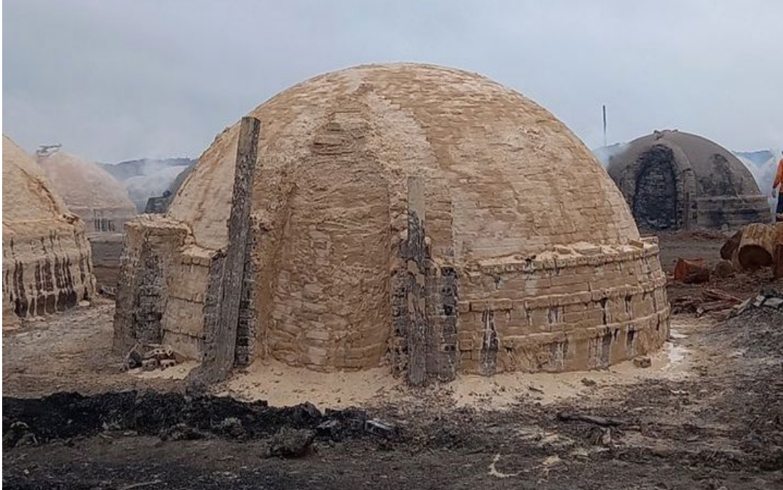
Figura 1 – Forno de alvenaria.
