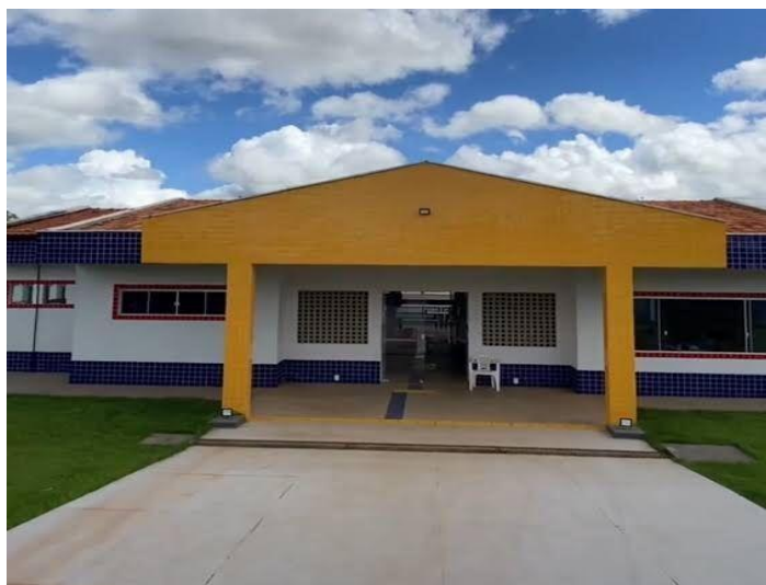
Imagem 1: Fachada da escola
