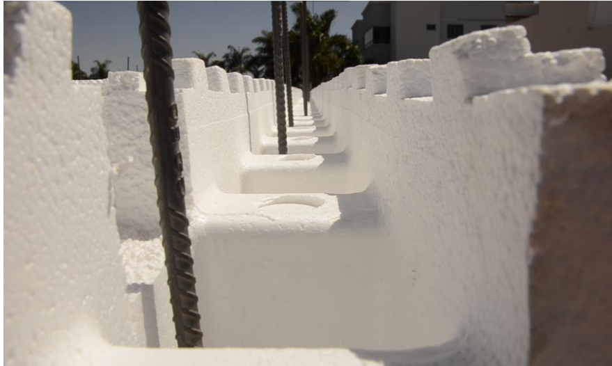
Figura 16 - ICF e barras de aço
