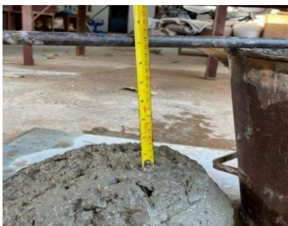
Imagem 3 – Slump Test do traço 1. Fonte: Autora (2023).
