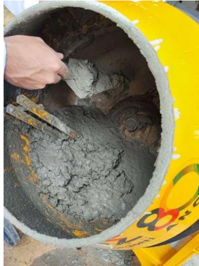
Figura 10: Teste prático de coesão e desprendimento do concreto, realizado no interior da betoneira.
