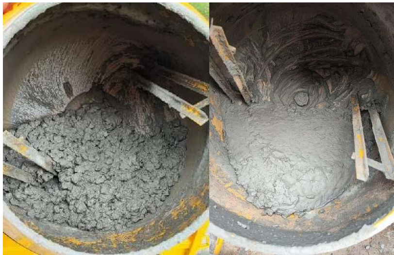
Figura 9: Teste prático de acabamento para determinação do teor de argamassa ideal, realizado no interior da betoneira.
