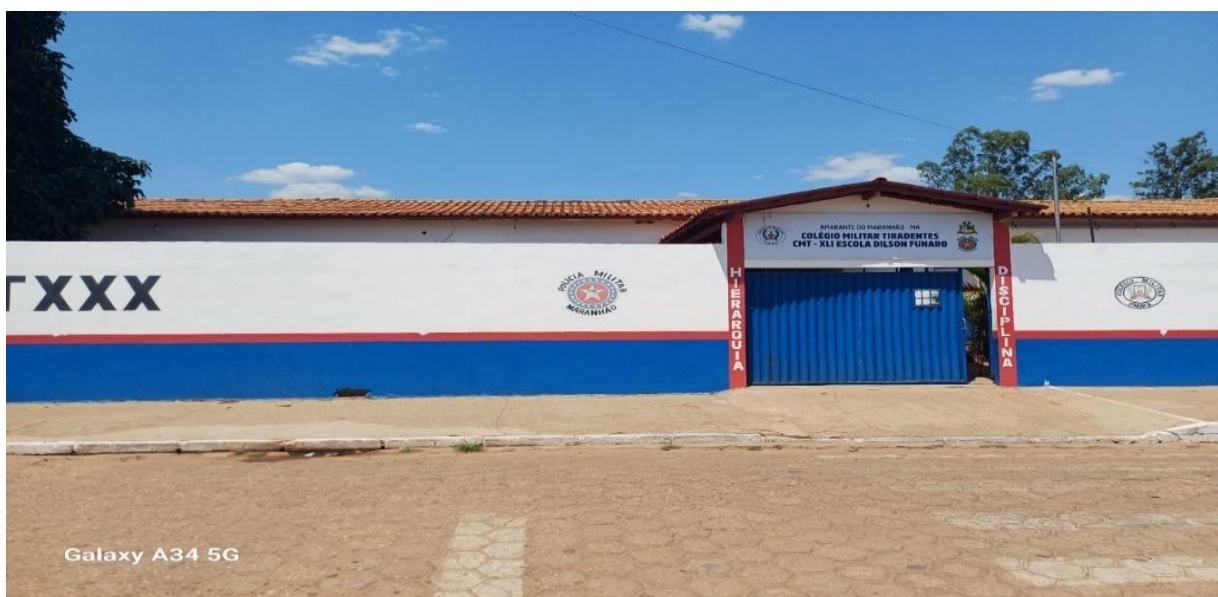
Figura 1: Faixada da escola.
