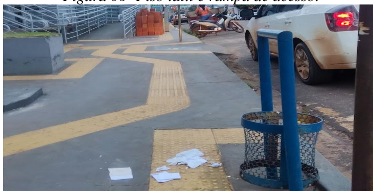
Figura 06- Piso tátil e rampa de acesso.
