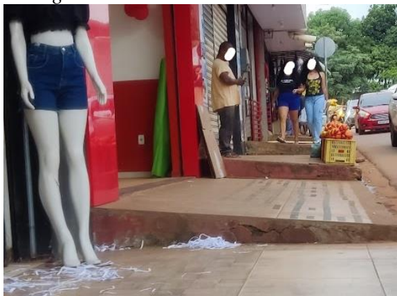
Figura 09- Descontinuidade entre lotes.
