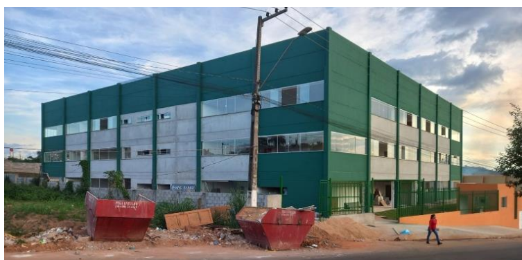
Figura 02 - Estabelecimento de ensino Fonte: Acervo da empresa que executou a obra (2023)
