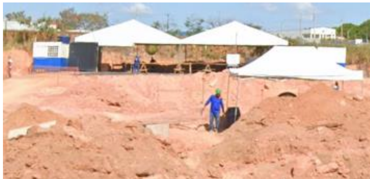
Figura 11 - Instalações do canteiro Fonte: Google Earth (2022)
