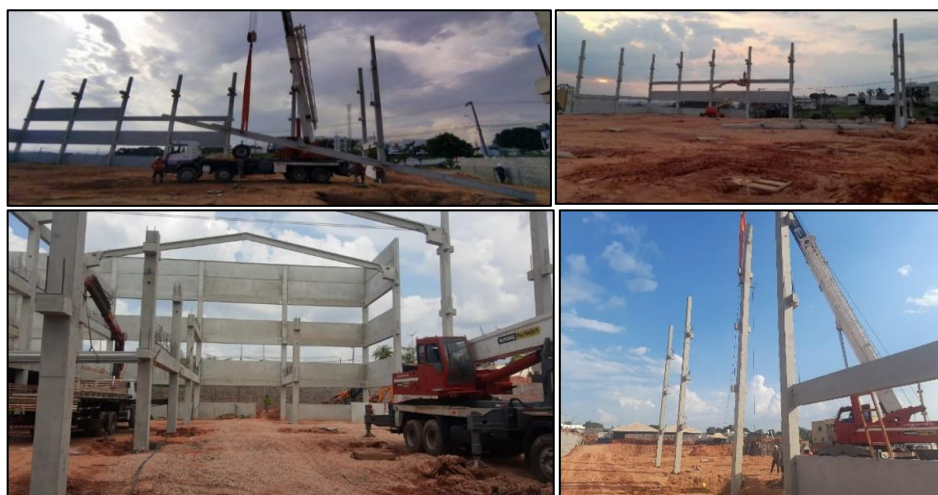
Figura 05 - Montagem da estrutura
