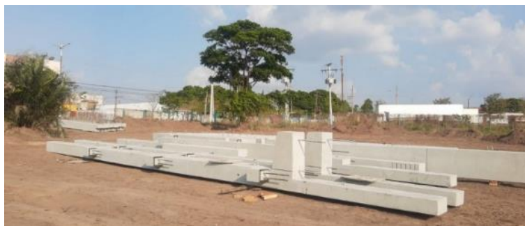
Figura 07 - Consolo dos pilares
