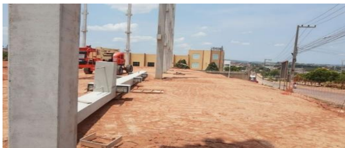
Figura 09 - Consolo com chumbador Fonte: Acervo da empresa que executou a obra (2023)
