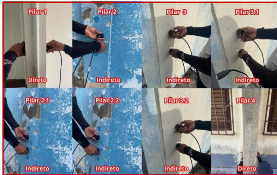
Figura 26 – Ensaio ultrassônico nos pilares do prédio: 29/01/2026 às 16h24.
