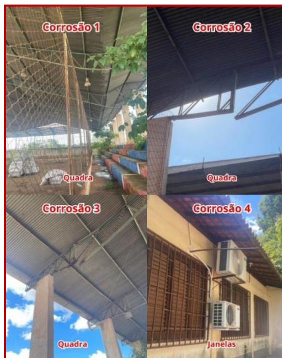
Figura 31 – Inspeção realizadas em: 14/10/2025 às 10h12.
