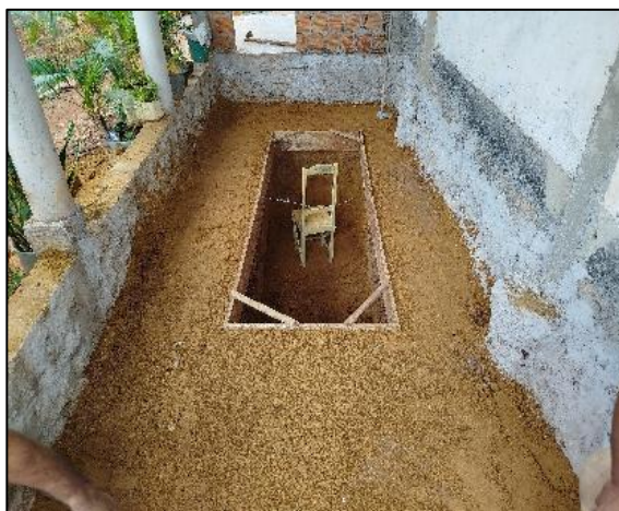
Figura 8: estrutura de forma aplicada na borda superior da cava do jardim.
