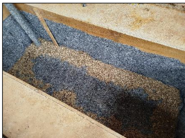
Figura 16: colocação da camada de seixo rolado.
