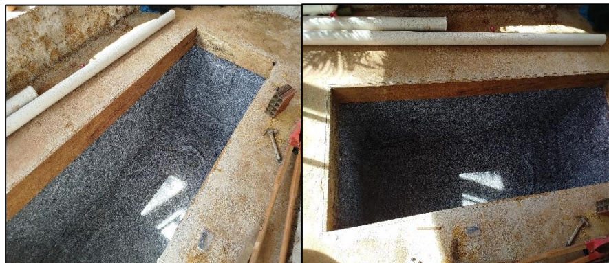
Figura 11: implantação da manta geotêxtil envolta da cava do jardim
