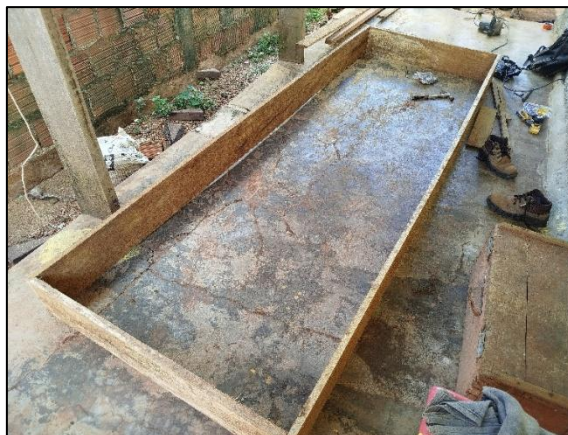
Figura 7: estrutura em fôrma de madeira.
