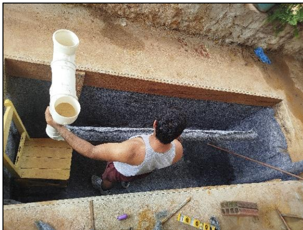
Figura 27: posicionamento da tubulação de entrada da água.
