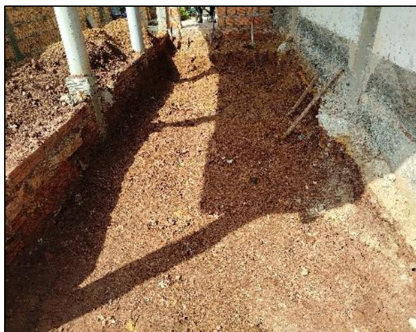
Figura 4: preparo e nivelamento do solo.
