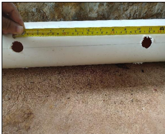
Figura 26: perfuração no tubo horizontal.
