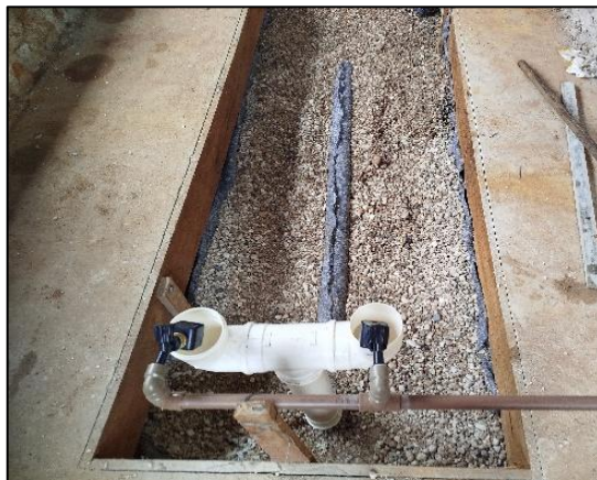
Figura 28: posicionamento da tubulação horizontal com materiais granulares
