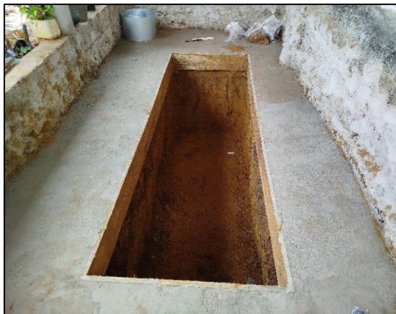
Figura 9: escavação finalizada da cava do jardim
