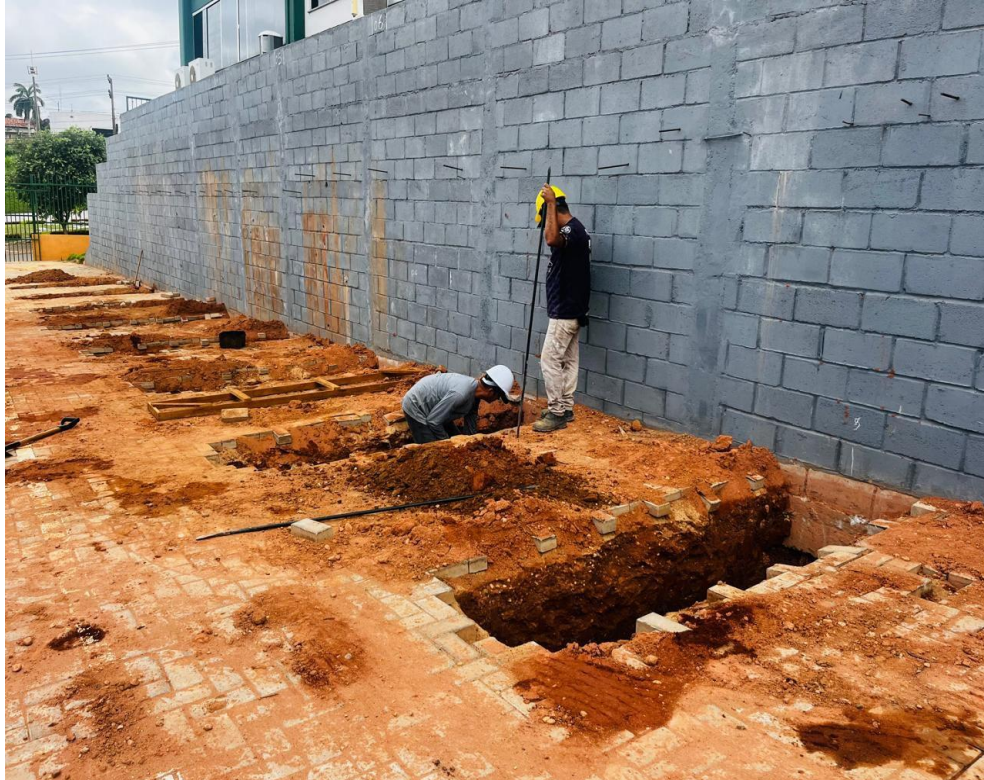
Figura 5: Escavação de valas para execução de fundações.
