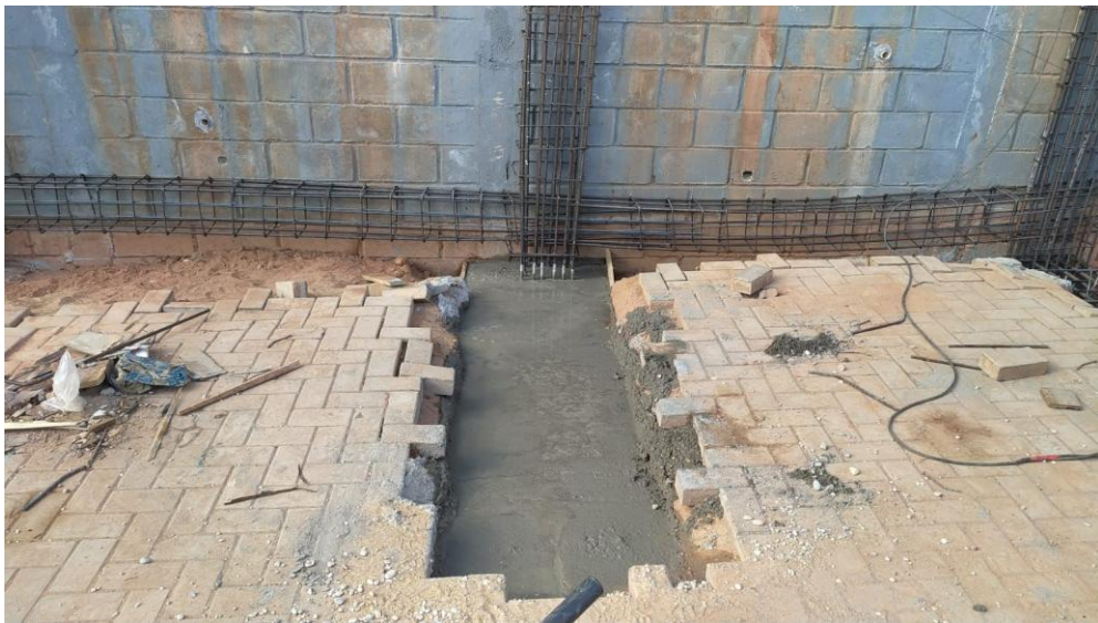
Figura 14: Concretagem do bloco escavado
