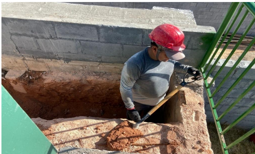
Figura 18: Escavação para reforço do solo.
