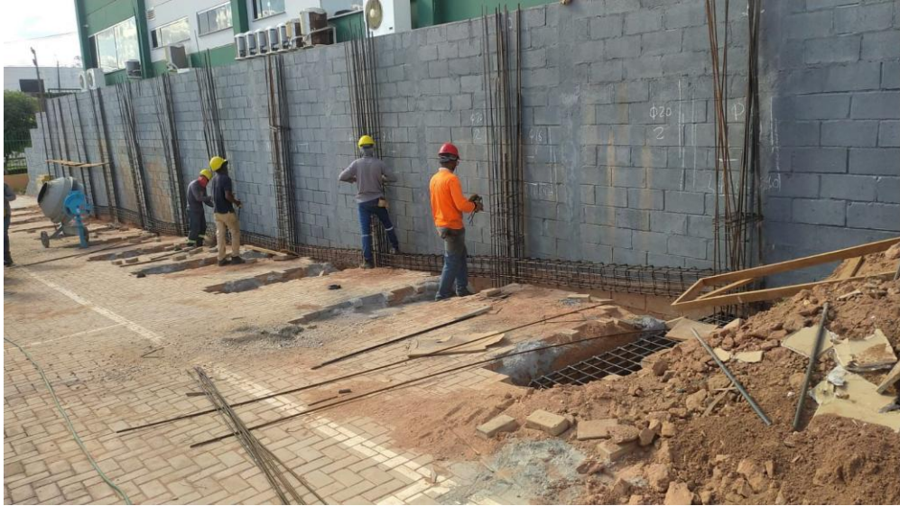
Figura 15: Armaduras de pilares e vigas.
