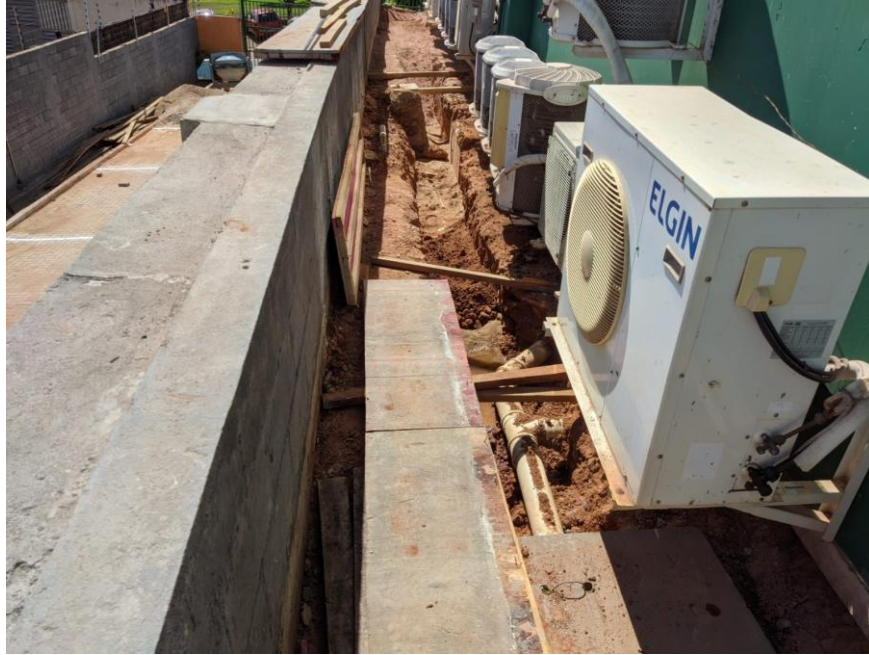
Figura 19: Escavação para reforço do solo.
