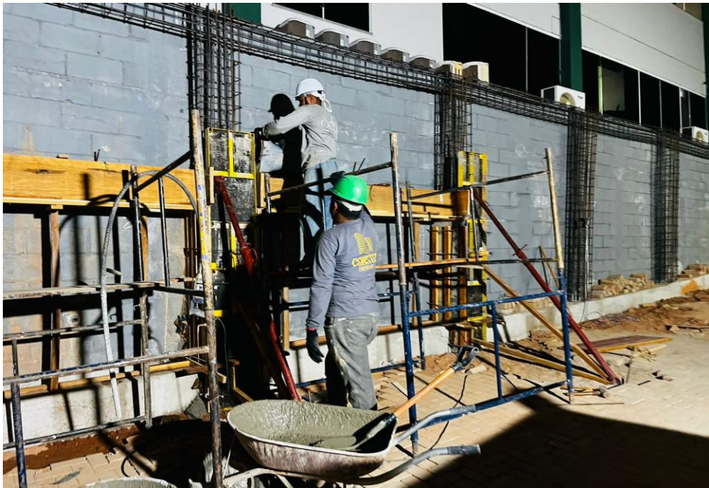
Figura 16: Armadura de pilares e vigas.
