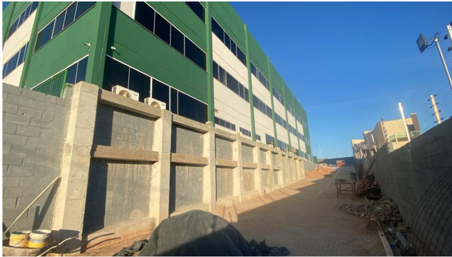
Figura 21: Muro após 31 dias após a concretagem
