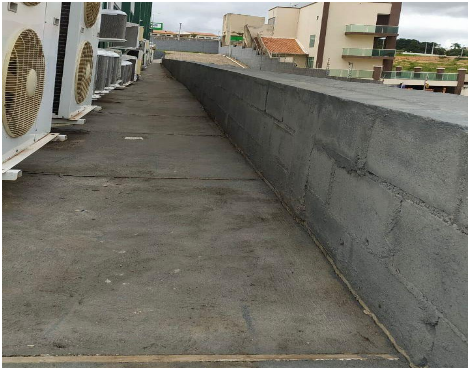
Figura 20: Piso e solo reforçado atrás do muro de contenção.
