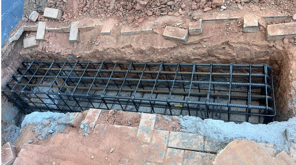
Figura 13: Armadura colocada no bloco escavado
