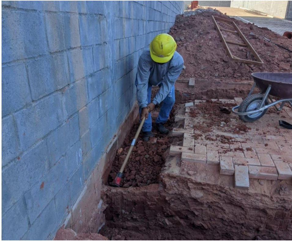
Figura 10: Escavação do pilar
