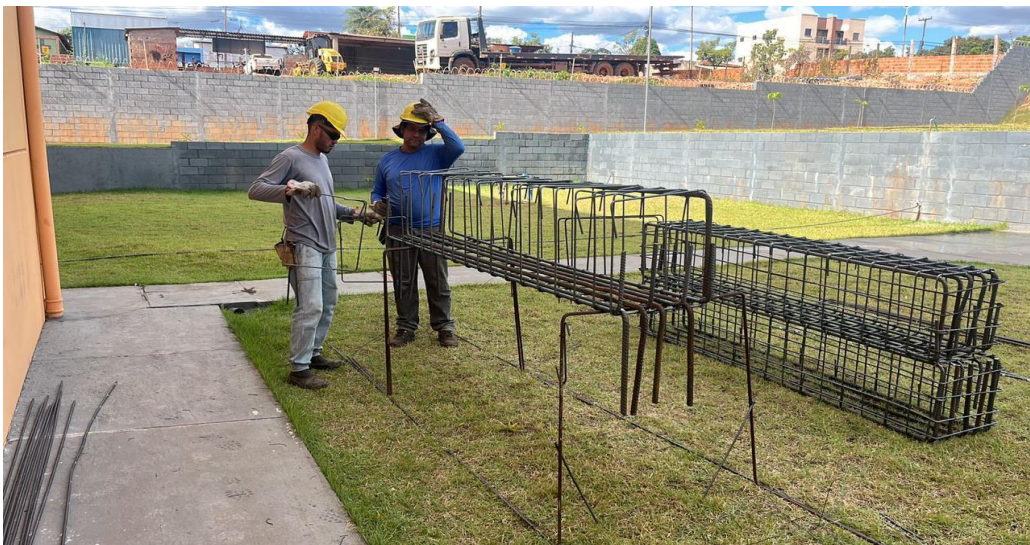
Figura 11: Montagem das armaduras
