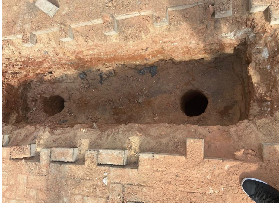
Figura 8: Bloco de fundação perfurado
