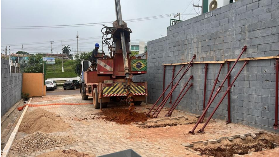
Figura 6: Perfuração do solo com trado mecânico (perfuratriz).
