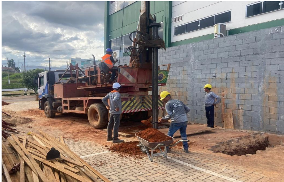
Figura 7: Perfuração de blocos de fundação da estrutura de contenção
