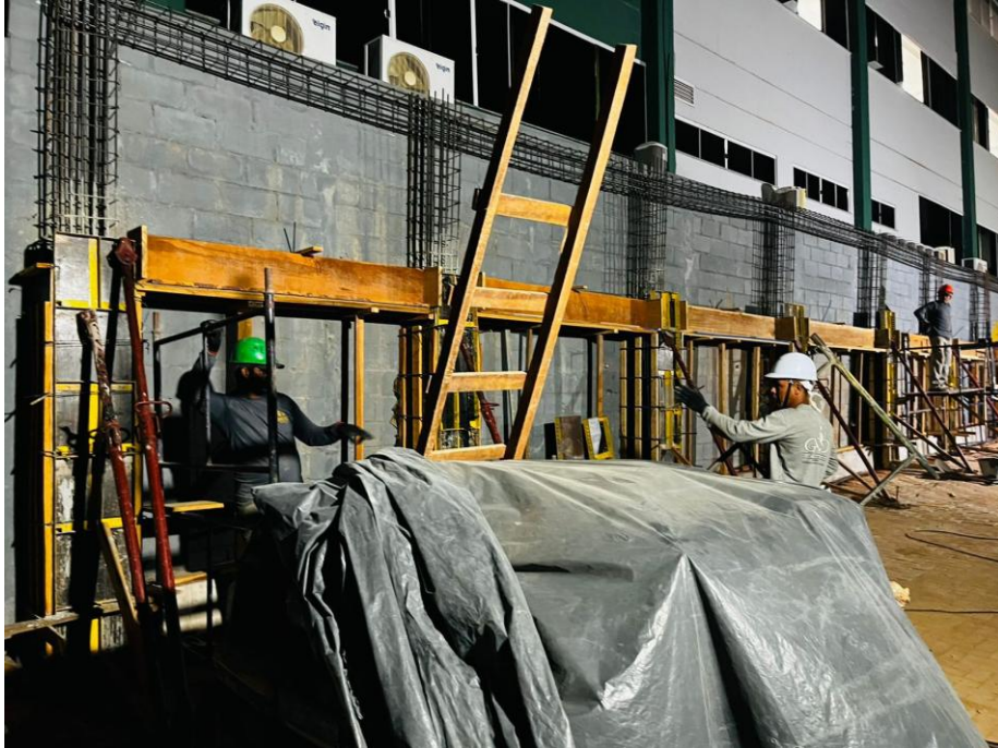
Figura 17: Montagem das formas de madeiras para a concretagem
