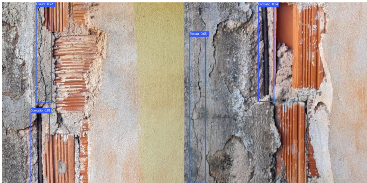
Figura 29 – Resultado de detecção para ambas as manifestações patológicas
