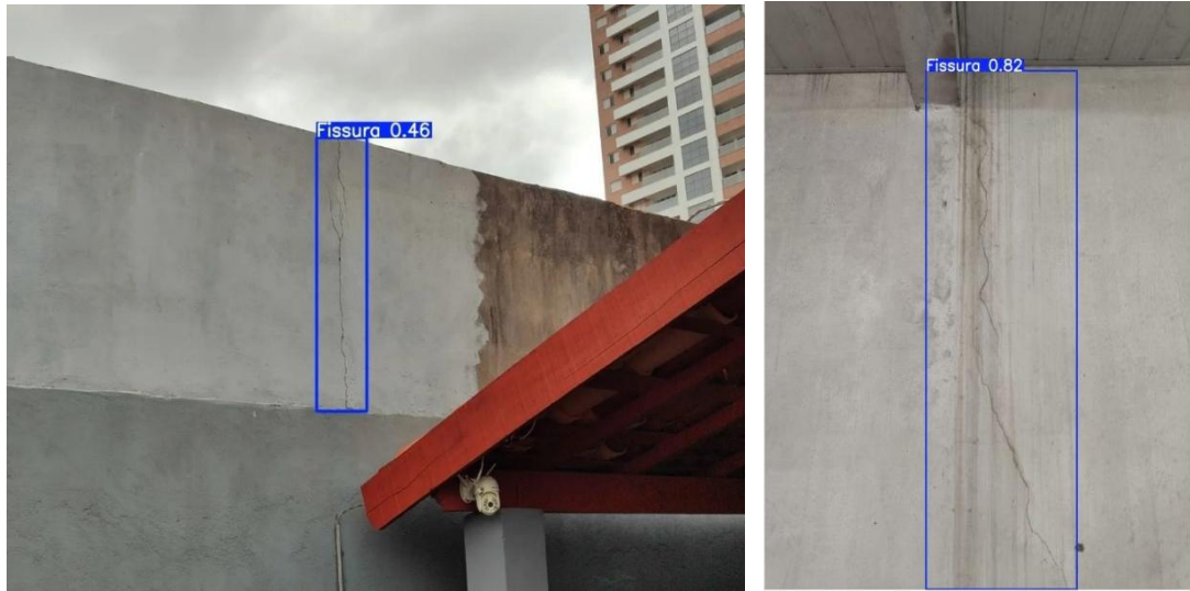
Figura 32 – Teste de detecção realizado remotamente pelo engenheiro 2
