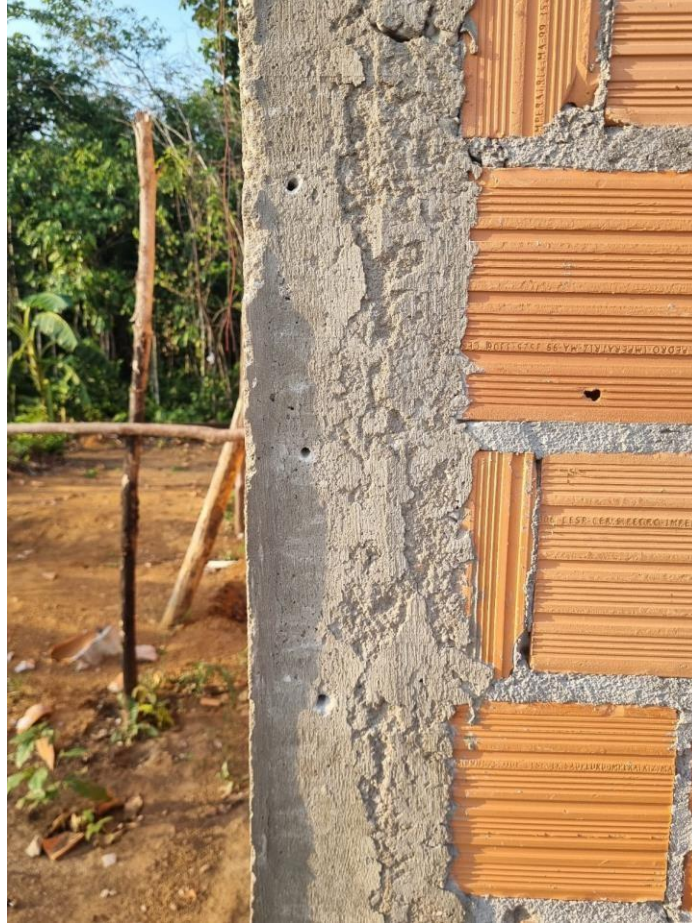
Figura 18-Furos realizados para coleta das amostras na estrutura localizada na área industrial
