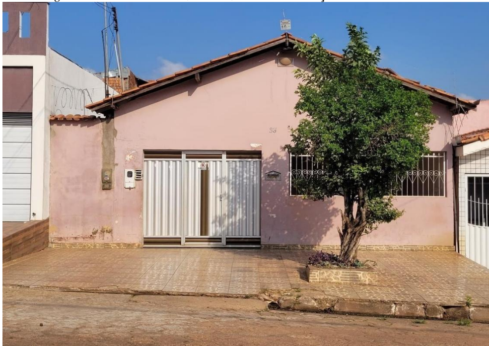
Figura 15-Estrutura localizada na zona urbana de Açailândia-MA
