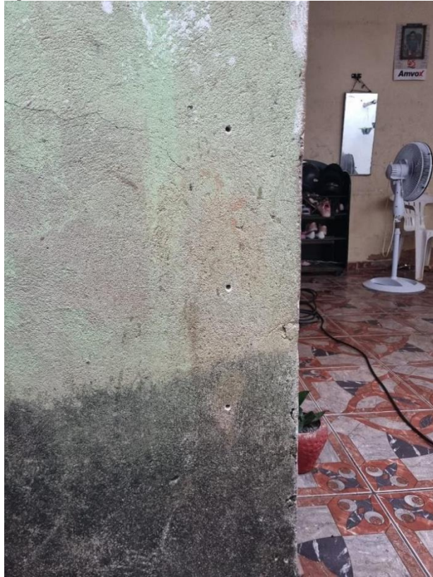
Figura 19-Furos realizados para coleta das amostras na estrutura localizada na zona industrial
