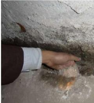
Figura 4-Expansão por ataques de sulfatos
