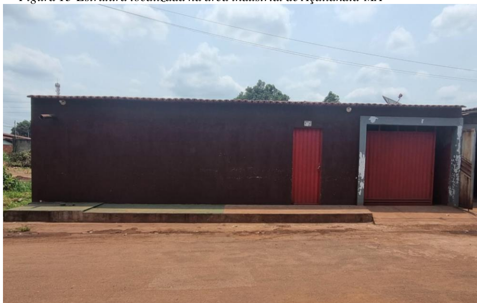
Figura 13-Estrutura localizada na área industrial de Açailândia-MA
