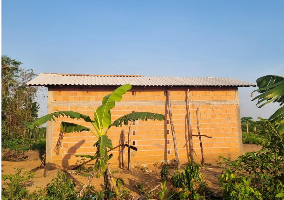
Figura 14-Estrutura localizada na zona rural de Açailândia-MA
