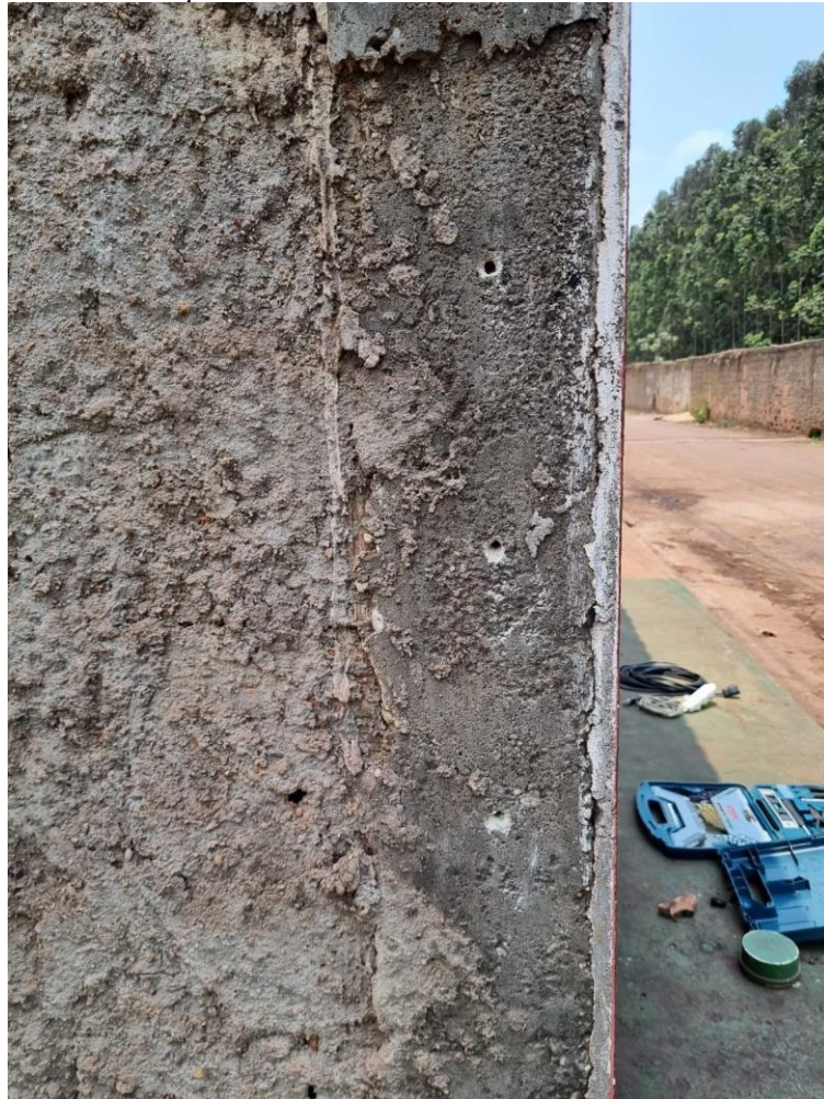
Figura 17-Furos realizados para coleta das amostras na estrutura localizada na área industrial
