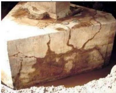
Figura 2-Reação álcali-agregados
