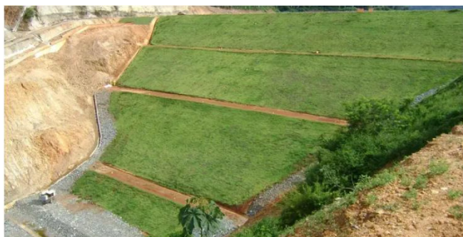
Figura 3: Talude depois do processo de Retaludamento Fonte: GOOGLE IMAGENS (2025)
