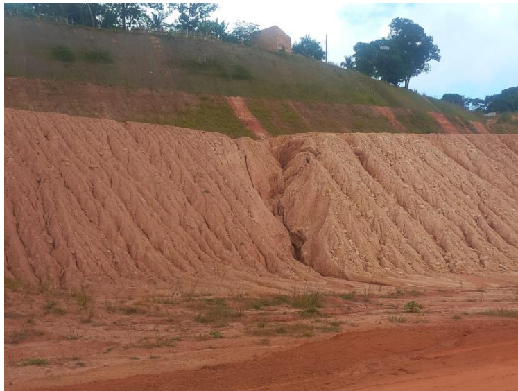
Figura 10: Talude após processo de Retaludamento
