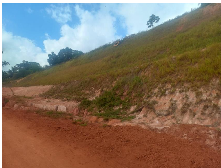
Figura 11: Revegetação do talude
