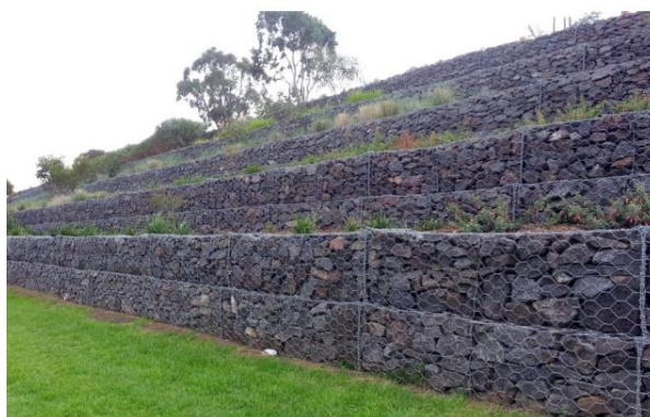
Figura 4: Muro de Gabião Fonte: GOOGLE IMAGENS (2025)
