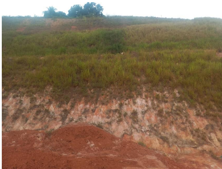
Figura 12: Revegetação do talude
