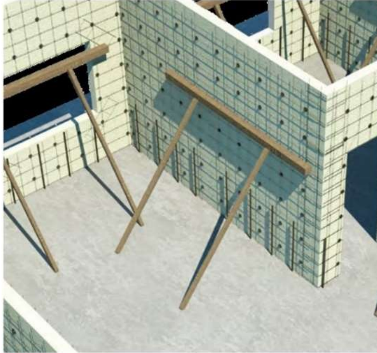
Figura 23 – Painéis sendo aprumados.
