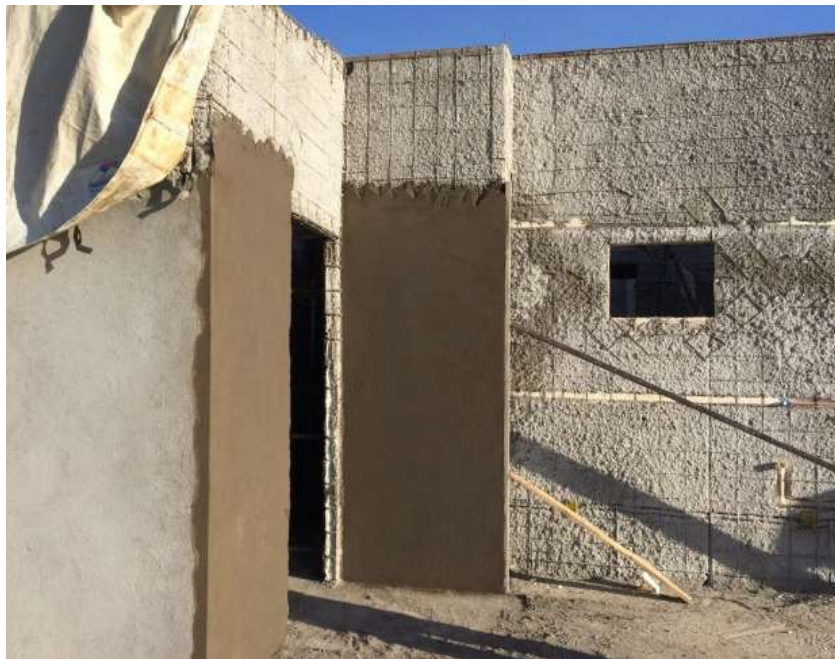
Figura 27 – Aplicação da segunda camada de revestimento.
