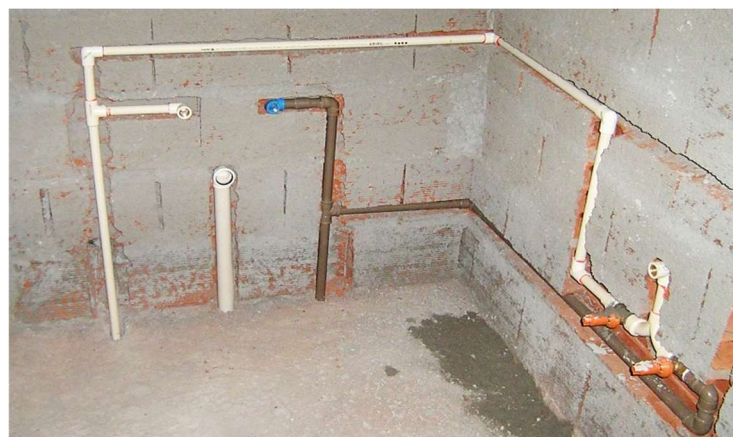
Figura 16 – Esquema de instalação da tubulação hidrossanitárias.
