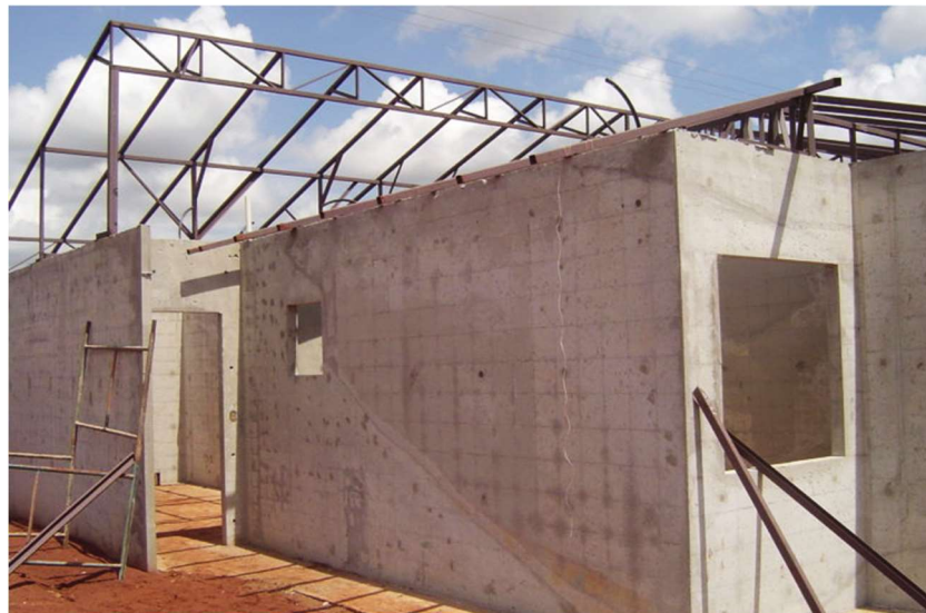
Figura 6 – Sistema com paredes estruturais.
