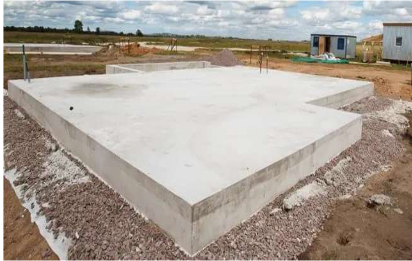
Figura 20 – Fundação tipo radier.
