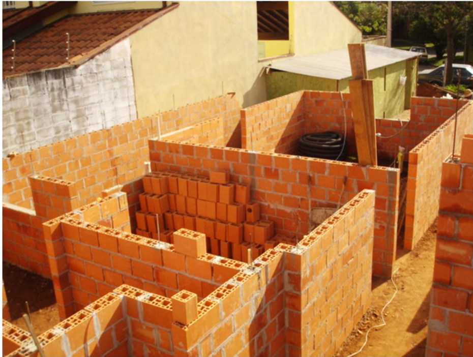
Figura 2 – Sistema de alvenaria estrutural com blocos cerâmicos.
