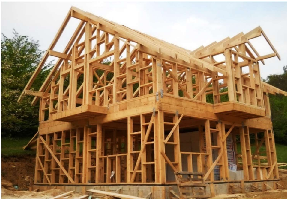
Figura 5 – Sistema Wood Frame.
