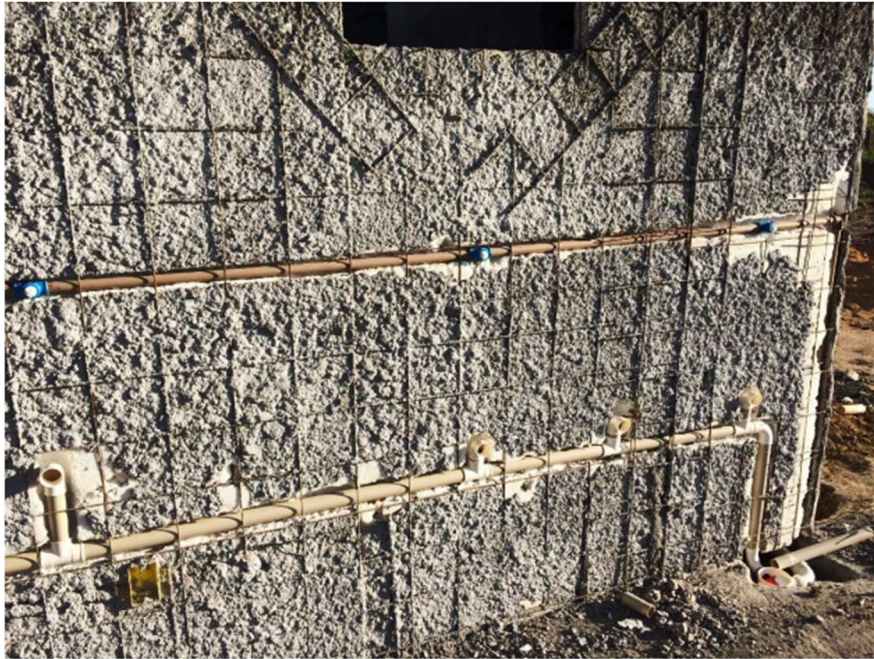
Figura 26 – Aplicação da primeira camada de revestimento.
