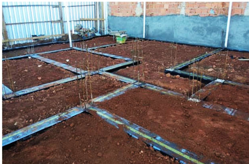
Figura 9 – Fundação tipo viga baldrame.
