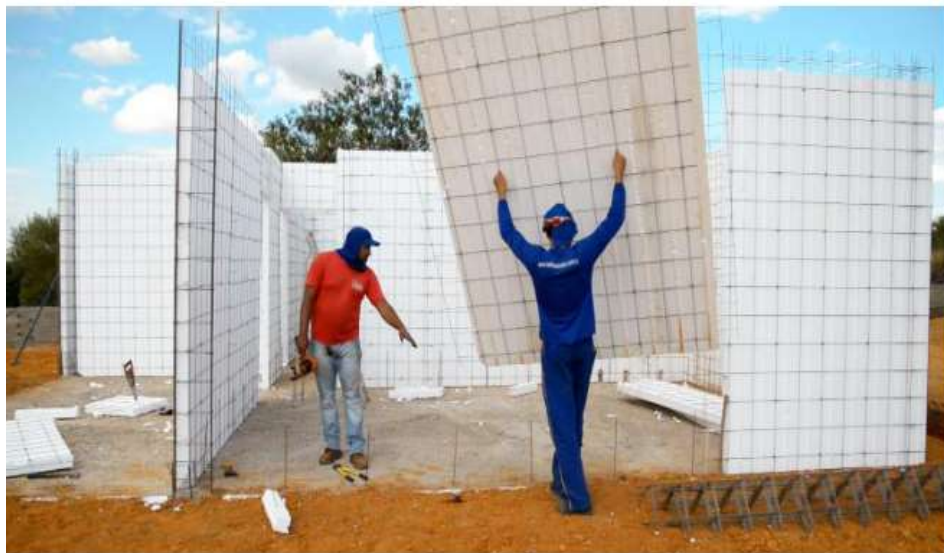
Figura 22 – Fixação dos painéis nas ancoragens.
