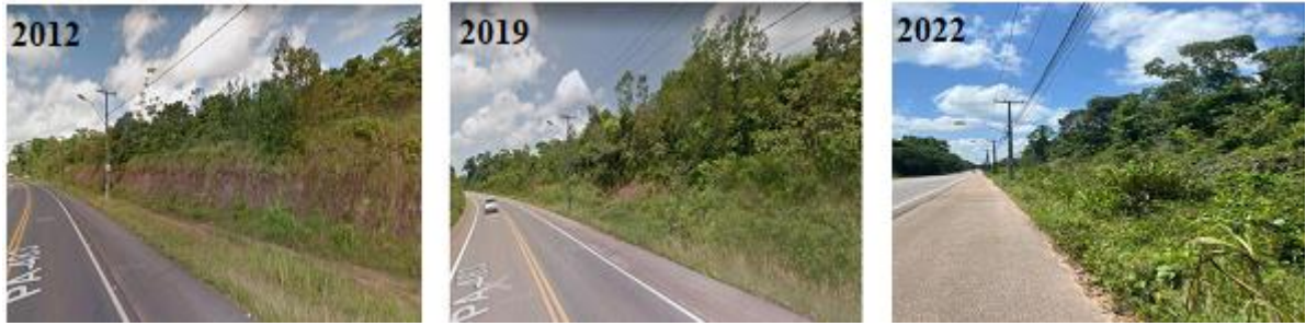
FIGURA 3. Registro fotográfico do ponto P1.
