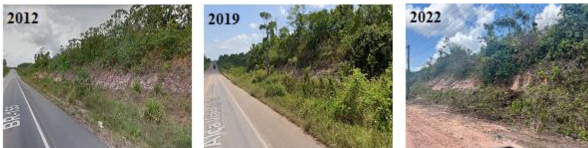
FIGURA 4. Registro fotográfico do ponto P2.
